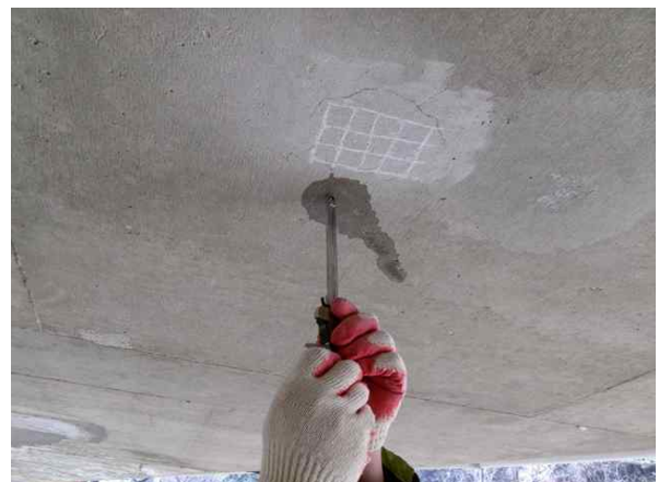
탄산화깊이 측정 현황
