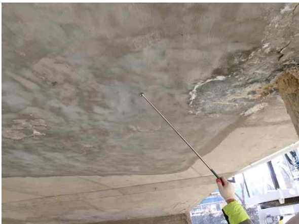
콘크리트 들뜸 작업전경
