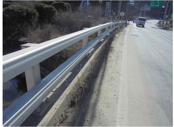
난간 및 연석 전경
